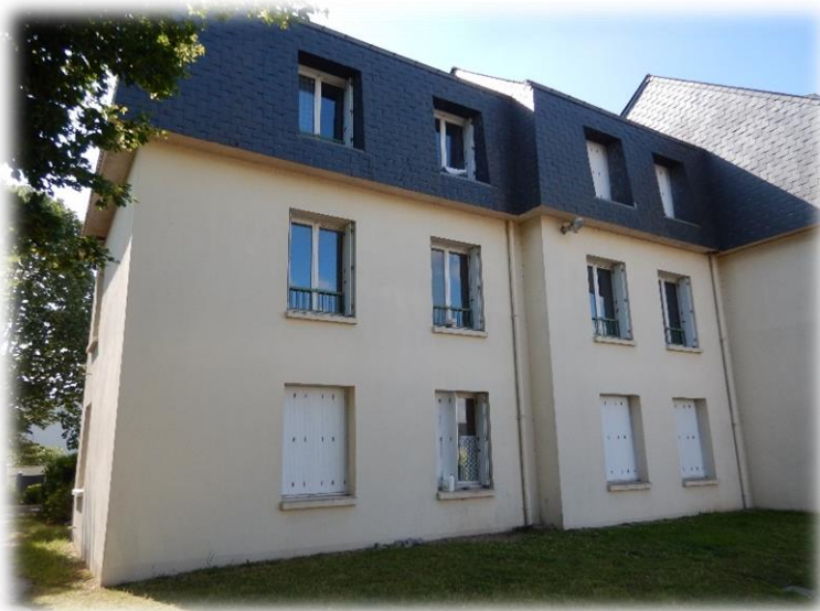
Figure 11 : Illustration du bâtiment et des volets en place
