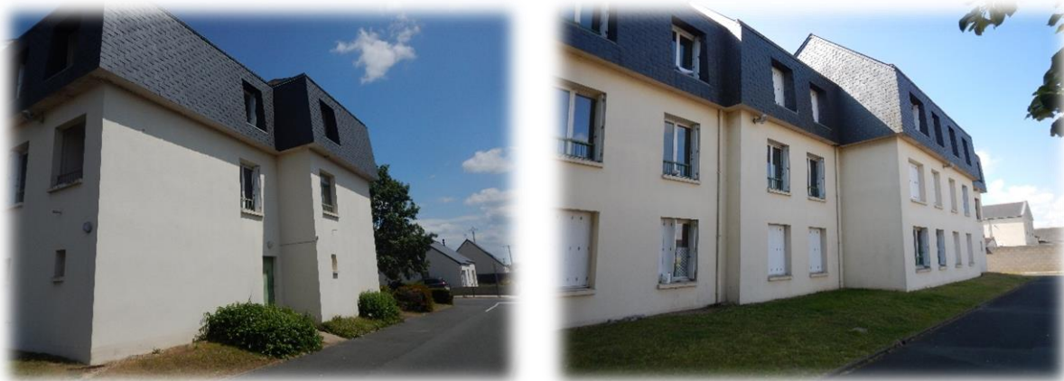
Figure 4 : Façade ouest (à gauche) et sud (à droite)
