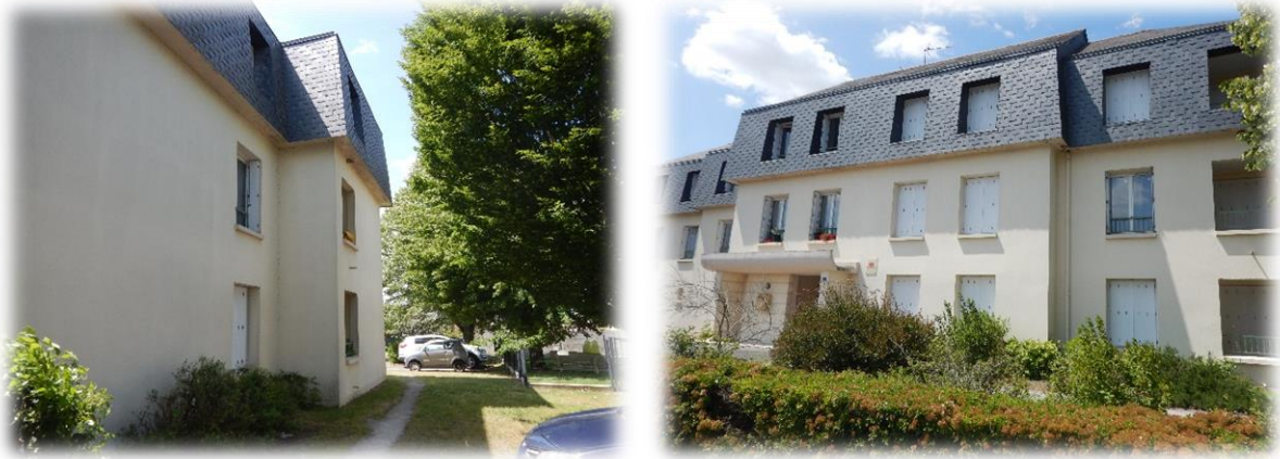
Figure 3 : Façade est (à gauche) et nord (à droite)
