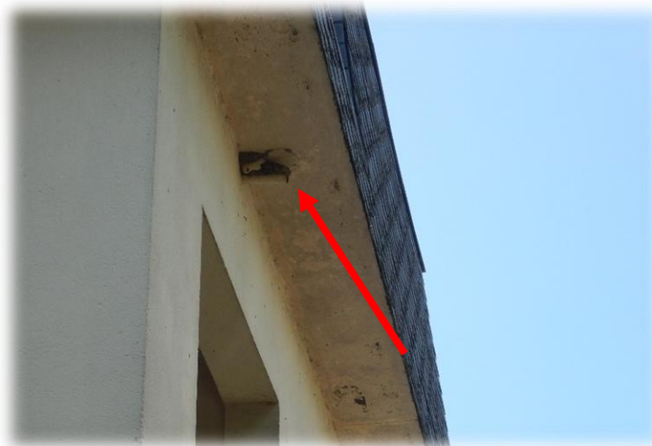
Figure 10 : Nid d'Hirondelle de fenêtre et traces d'un ancien nid, présent sur la façade nord-est
